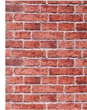
Pour construire un mur solide, il faut **alterner** les briques : au lieu de les poser les unes sur les autres, on les pose en **quinconce** : chaque brique du dessus se place **au milieu** par rapport aux deux du dessous.
